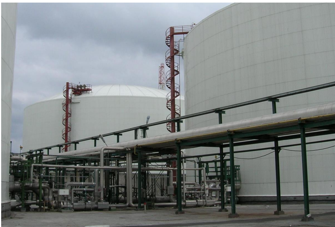
Serbatoi di ammoniaca.
