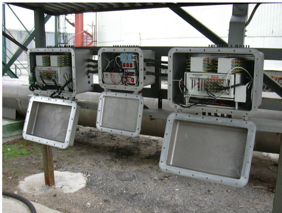
Sistema di misura del serbatoio numero 3.
